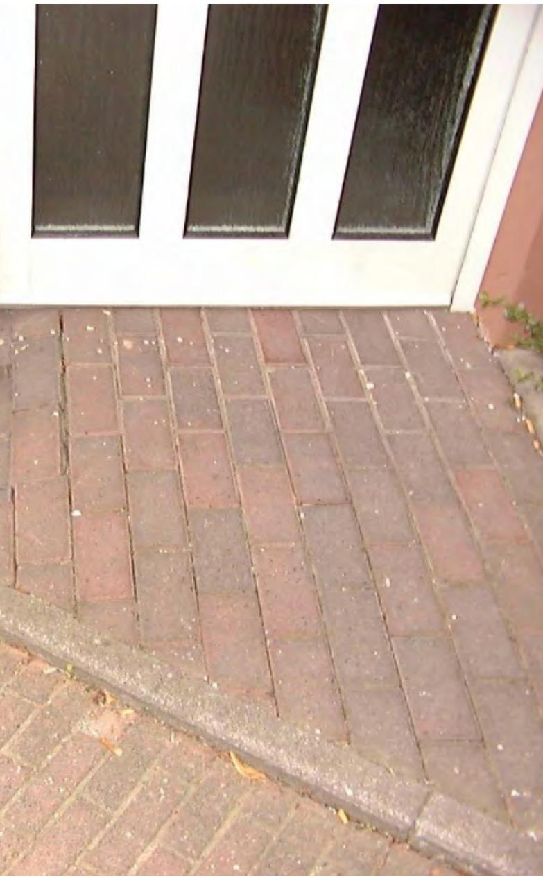
Abb. 12: Abgesacktes Gehwegpflaster aufgrund von Unterhöhlung durch Ratten
