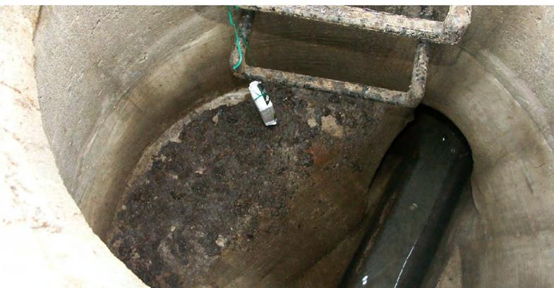
Abb. 24: Kanalschacht mit eingehängtem Formköderblock | Quelle: Daniel Krämer
